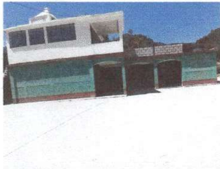
FOTO 1: Se encuentra el primer módulo con 5 aulas que se han sustituido piso cerámico duela; incluyendo un aula en el segundo nivel.
