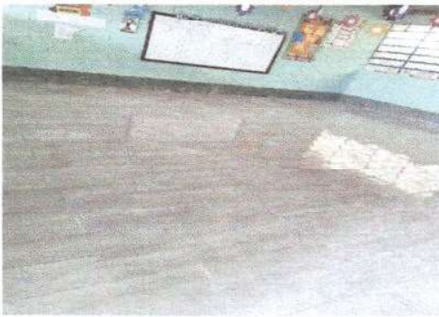
FOTO 3: Se observa la culminación de sustitución de piso cerámico duela en una de las aulas del Centro Educativo.
