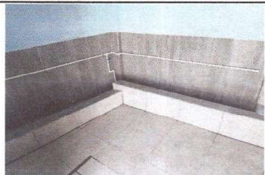
Foto 6: En la foto se observa la parte interior del mingitorio ya terminado.
