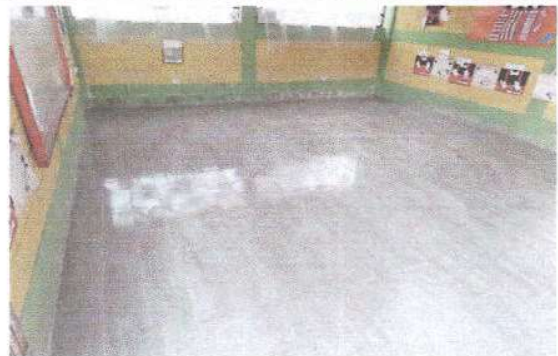
Foto 4: En la Foto se muestra el acabado de sustitución de piso cerámico duela en una de las nueve aulas.
